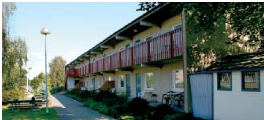
Loftgångshuset på Trädgårdsvägen ska i framtiden att värmas med bergvärme.
