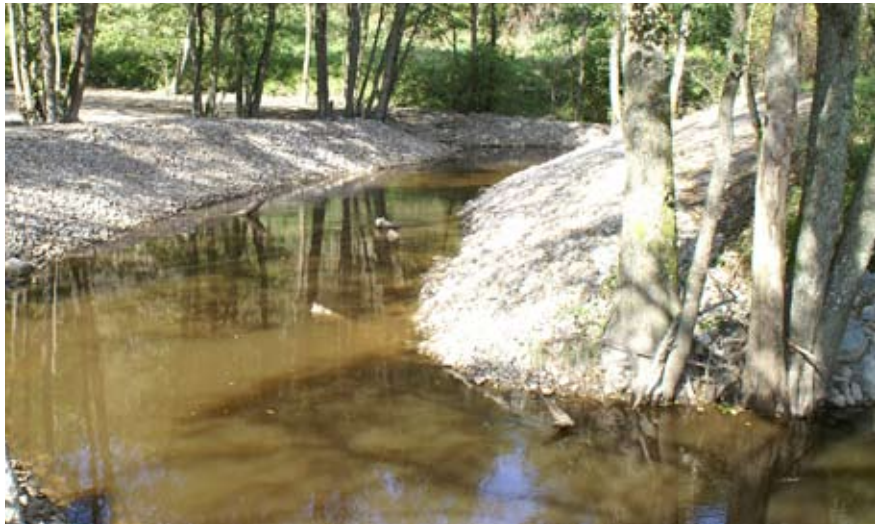
Den nya åfåran i Alafors har fyllts upp med grus och större stenar för att behaga lax och öring under deras lekperiod.
