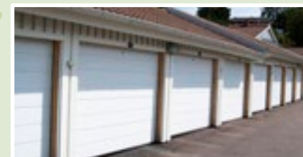
Nya garageportar på Carlmarks väg.
