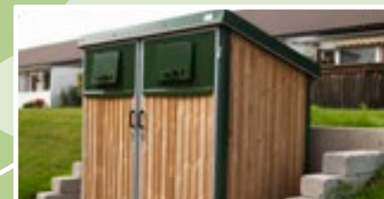
Nya miljöstationer på Alehemsvägen.
