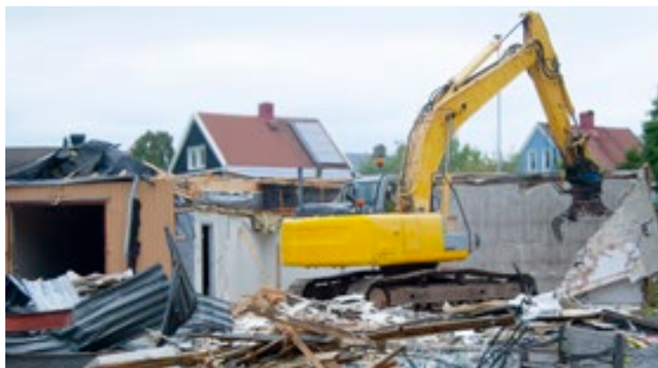
Rivningen av Alebyggens gamla expedition och garagelängorna inleddes i augusti. BILD: MAGNUS SOOVIK
