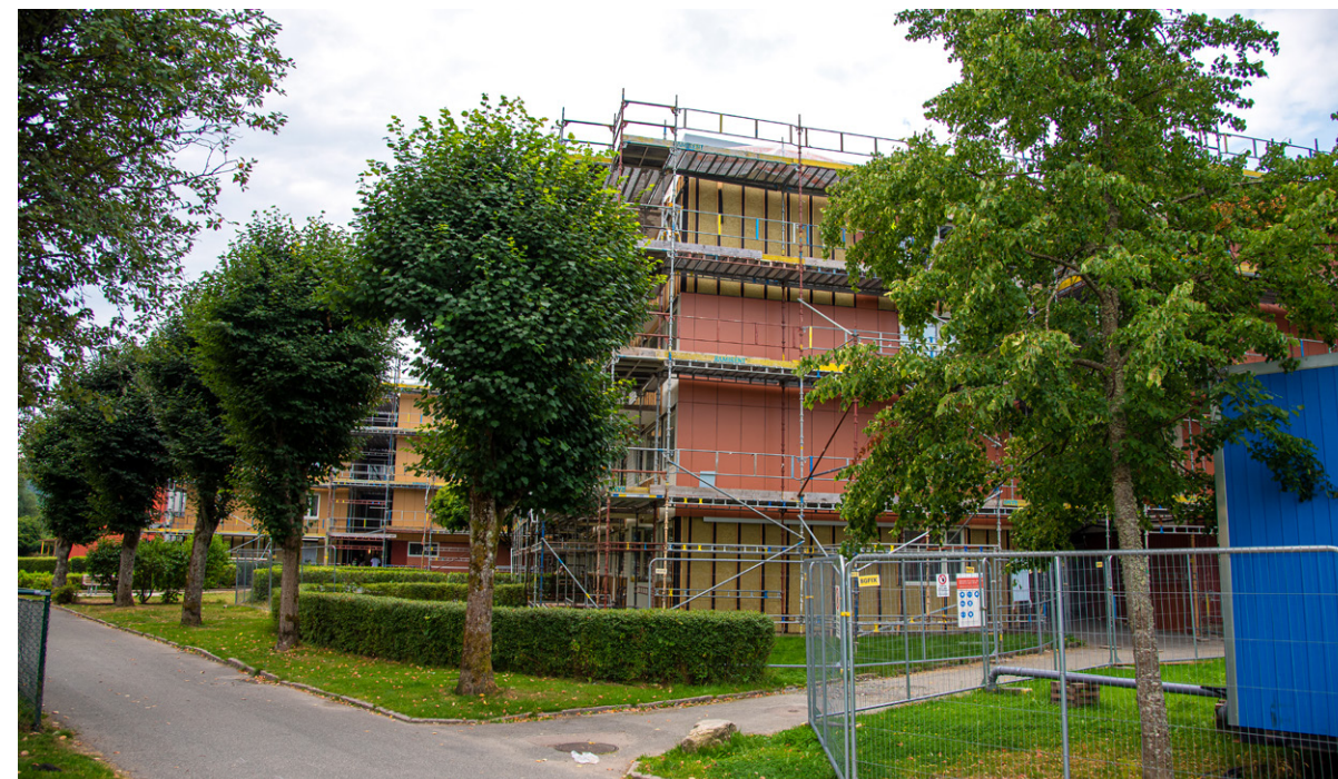
Arbetet med fasaderna på Mossvägen 3 och 5 har dragit ut på tiden på grund av leveransproblem.
