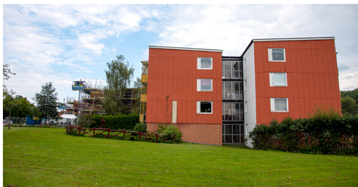
Mossvägen 1 har sättningar i grunden och kommer därför att rivas. Det ersätts av ett likadant hus som byggs på Folketshusvägen 14.
