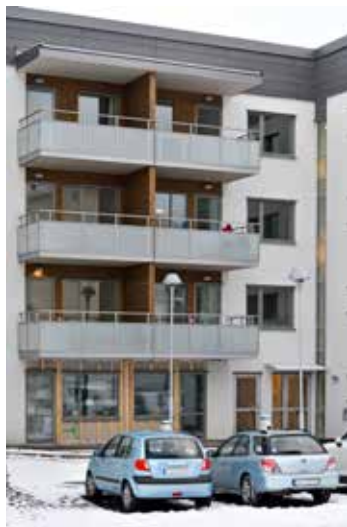
Lägenheterna har antingen balkong eller egen uteplats. Det finns också en gemensam uteplats.
